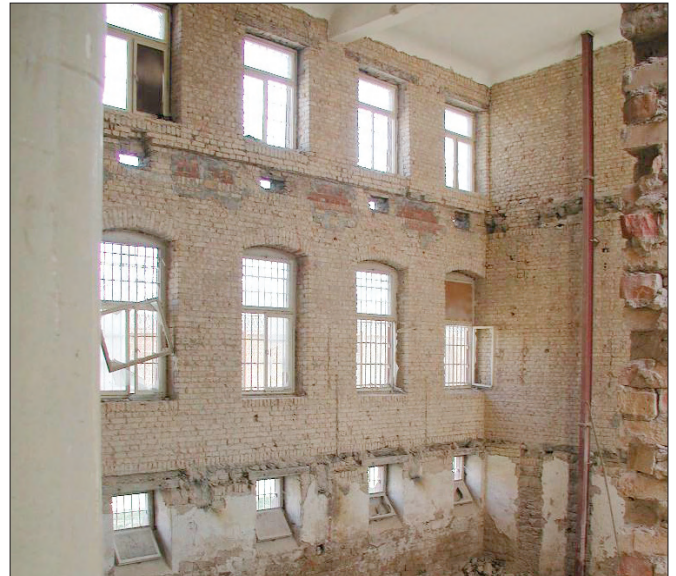
Altes Wirtschaftsgebäude Umbau 2003
