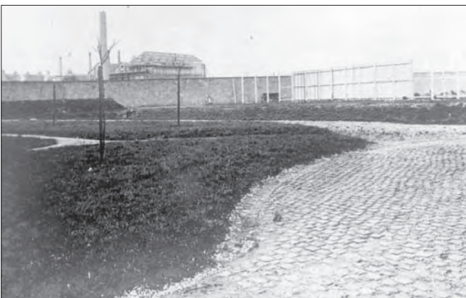
JVA im Bau 1915
