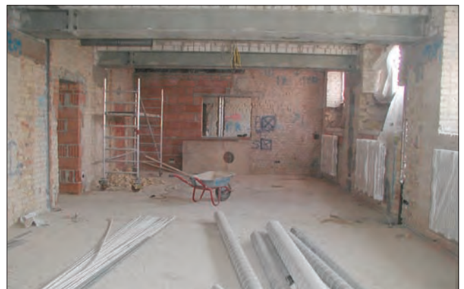
Besuchsabteilung im Bau
