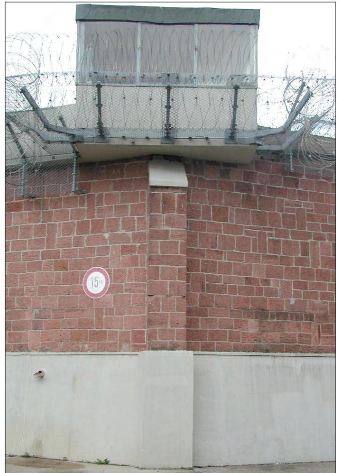
Mauerposten von 1962 bis 2004
